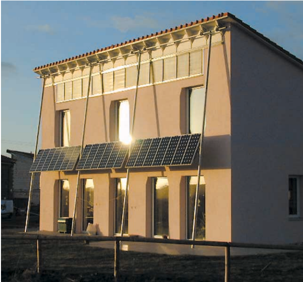
Bild 7 Rahmenmodule als Blickfang an einer Hauswand
