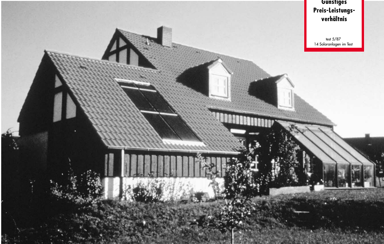
Bild 1. Ein 5 m 2 SB-Sonnenkollektor mit senkrechter Absorberanordnung, der sich aufgrund seiner integrierten Bauweise gut ins Dach einfügt.
