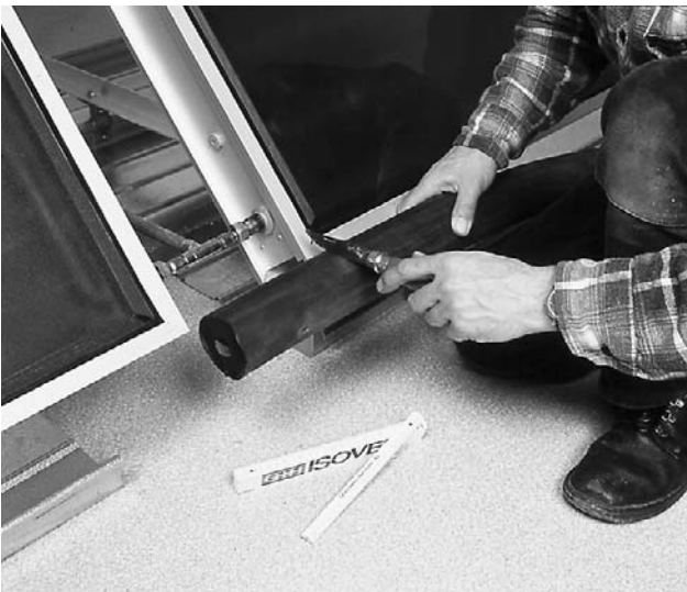
Bild 19 Nach Abdrücken des Solarkreises Rohre mit temperatur- und UV-beständiger Wärmedämmung isolieren.
