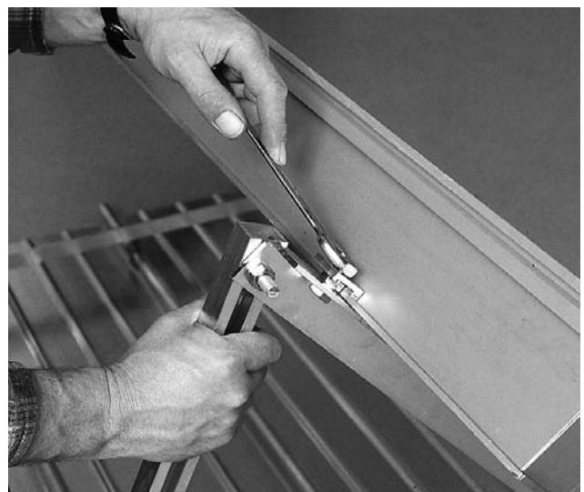
Bild 16 Kollektor mit EURO-Befestigungsklemmen so an Kollektorprofil (Bauteil ①, S. 2f) fixieren, dass höherer Absatz (mit geprägtem Pfeil) zum Kollektor zeigt (s. Lupe Bild 2).
