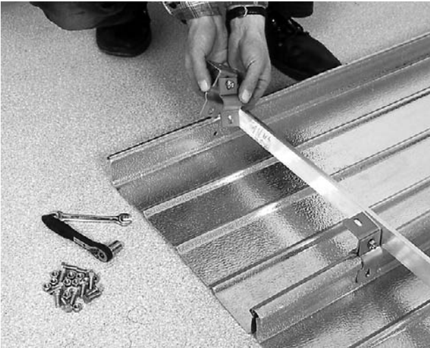
Bild 11 Zwei Bodenprofile (Bauteil ②, S. 2f) pro Kollektor auf Kiesplatten legen (Abstand zu Kollektorändern 5-10cm), Falzblechhalter daran ausrichten und mit oberer Schraube festklemmen.
