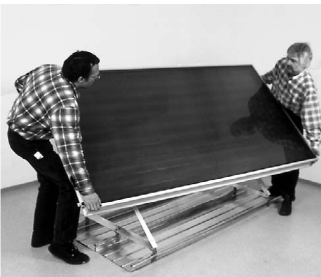
Bild 15 Zwischen den herausragenden Schrauben den Kollektor so einsetzen, dass er mit oberer und unterer Mutter abschließt.
