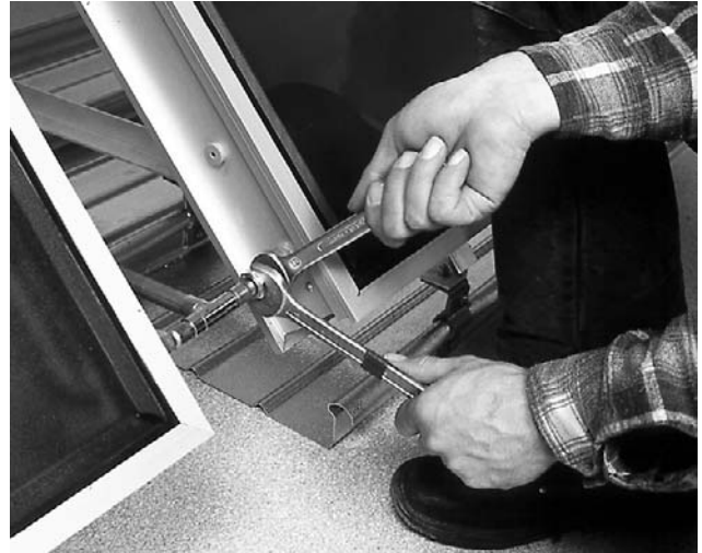
Bild 18 Gegenhalten beim Festziehen schützt Kollektoranschluss vor Schäden.
